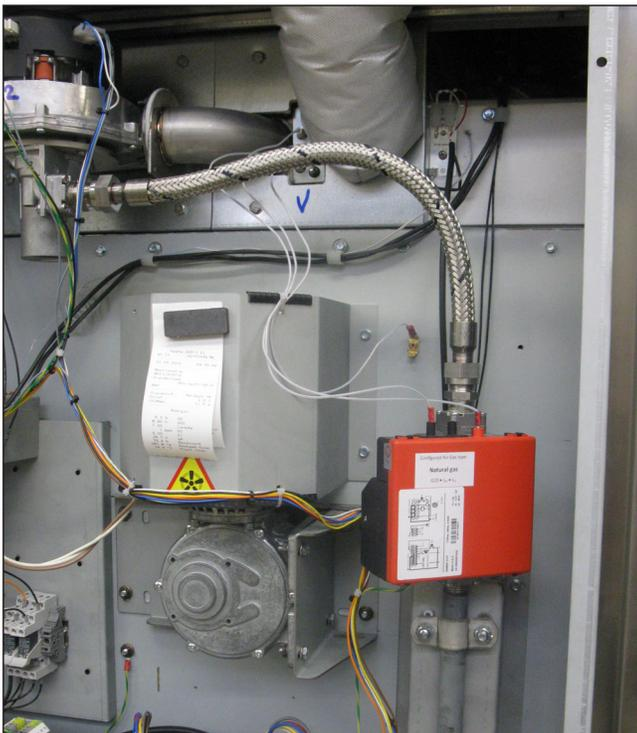
1. Retire el tornillo que asegura el control del quemador en el bloqueo de gas y retire el control del quemador deslizando hacia la izquierda.
