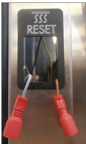
2. Conecte estos 2 enchufes juntos con un cable separado.
